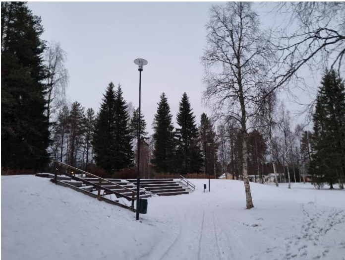
Katsomorakenne puiston keskellä.
